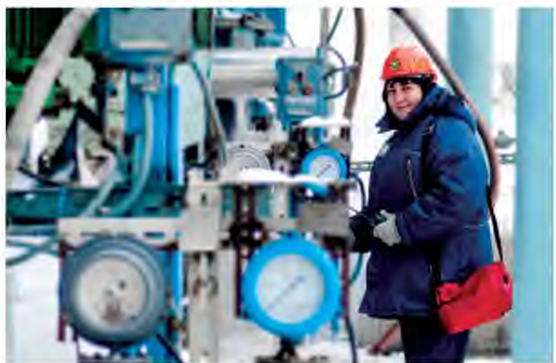
Каждый час через изотермические хранилища на производство карбамида в качестве сырья перекачивают до 60 тонн аммиака
